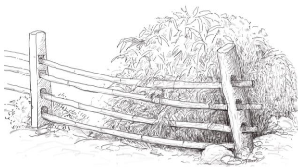
ภาพที่ 12 รั้วตั้งบ่อง เป็นรั้วสำหรับการกั้นคอกวัวหรือควาย โดยคำว่า “บ่อง” หมายถึงการเจาะรู เพื่อเอาไม้ไผ่ใส่เข้าไป ในรูนั้นเพื่อกำหนดขอบเขตของรั้ว
