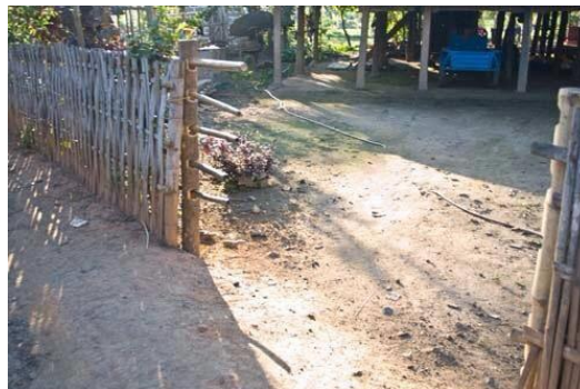
ภาพที่ 12 รั้วตั้งบ่อง เป็นรั้วสำหรับการกั้นคอกวัวหรือควาย โดยคำว่า “บ่อง” หมายถึงการเจาะรู เพื่อเอาไม้ไผ่ใส่เข้าไป ในรูนั้นเพื่อกำหนดขอบเขตของรั้ว
